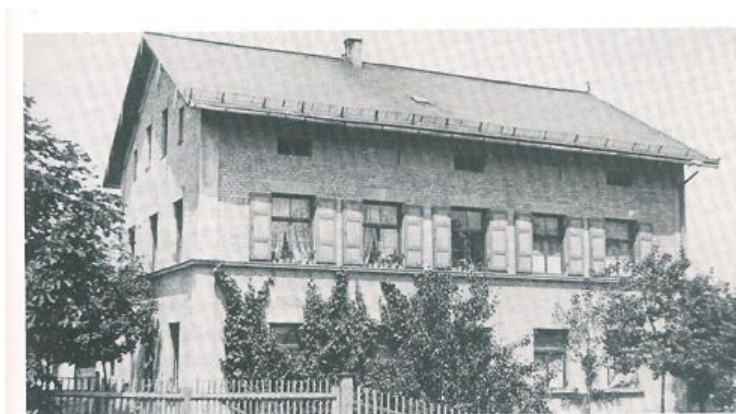
Alte Schule an der Friedberger Straße
